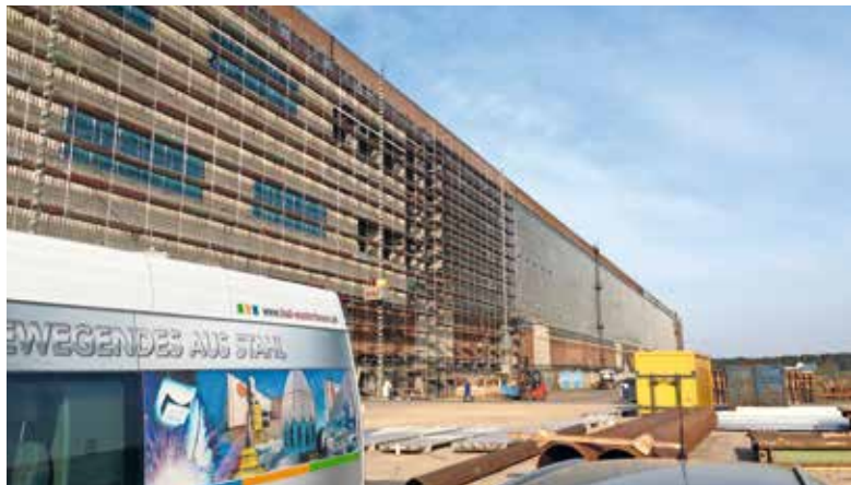
Die Sanierungsarbeiten an der Turbinenhalle auf dem Gelände der Energiewerke Nord stehen kurz vor Vollendung. Mit fast 1000 Metern Länge zählt die Halle zu den längsten Industriebauten in Deutschland.
